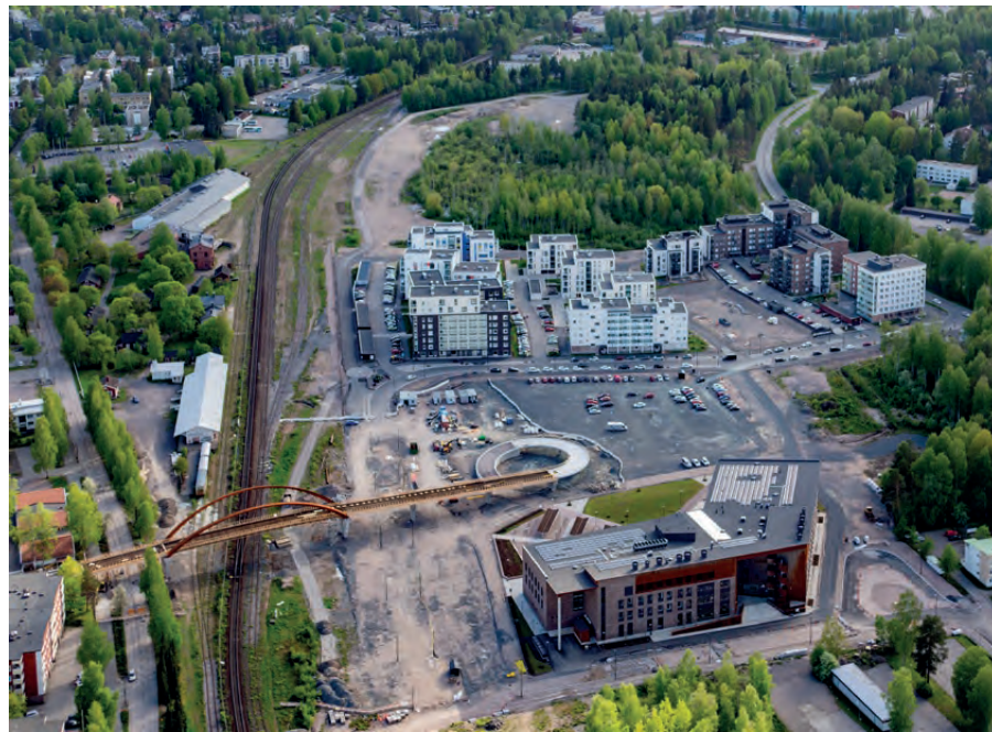
Ilmakuva Hangonsillan alueesta 24.5.2021.
