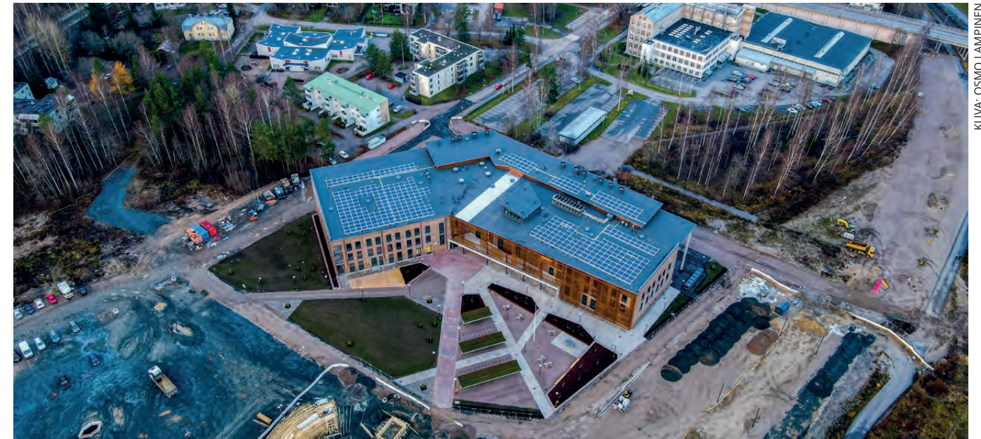
Hyvinkään lukio ja Hyvinkään Opisto sijaitsevat Kipinä-talossa, jonka katolla on 400 aurinkopaneelia.
